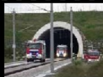
Einsatzübung Tunnel Pottenbrunn
